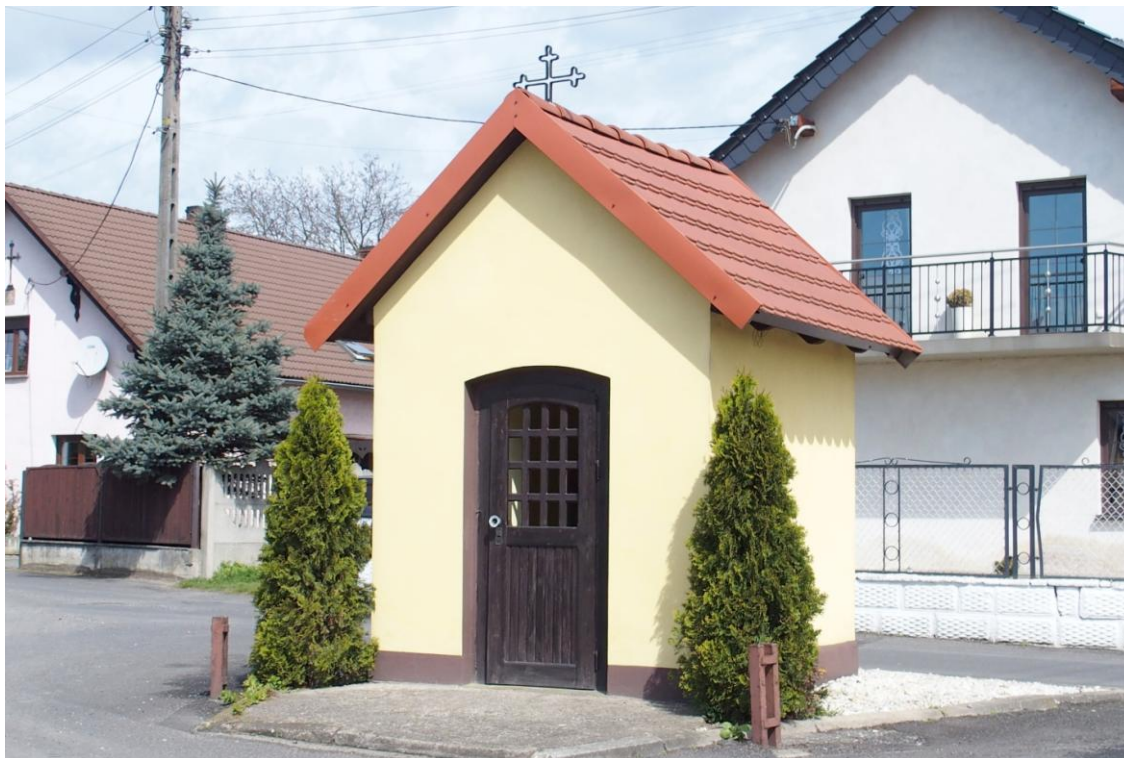
Widok od południowego-wschodu
