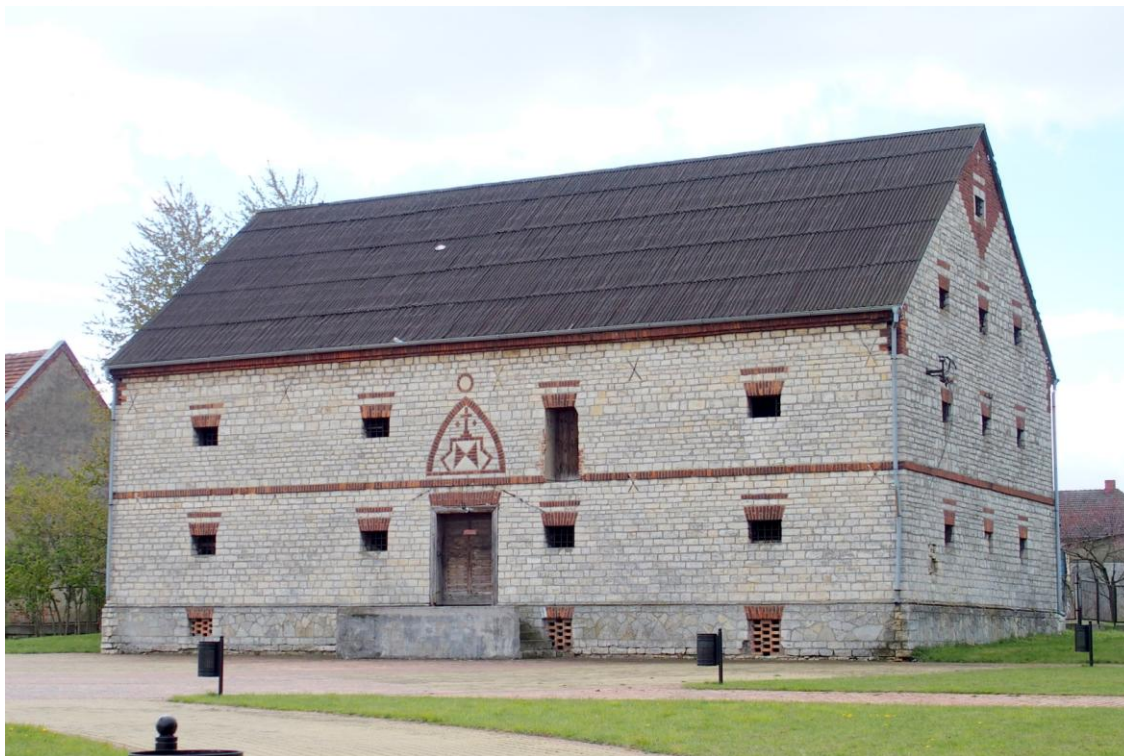
Widok budynku od północy
