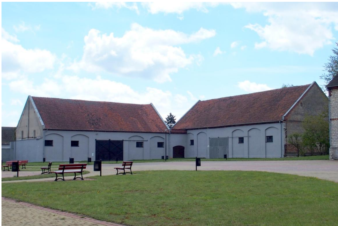
Widok budynków od północnego-zachodu
