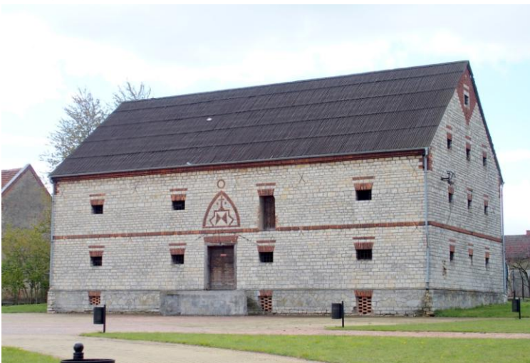
Spichlerz, widok budynku od północy
