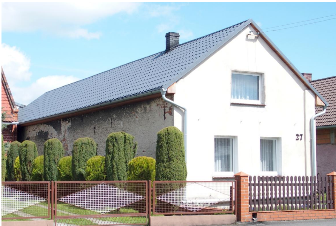
Widok budynku od południowego-zachodu
