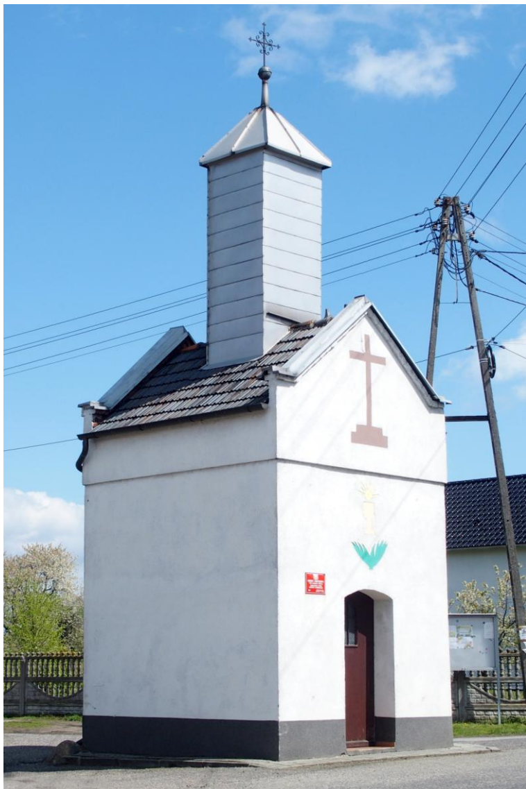
Widok od południowego-zachodu
