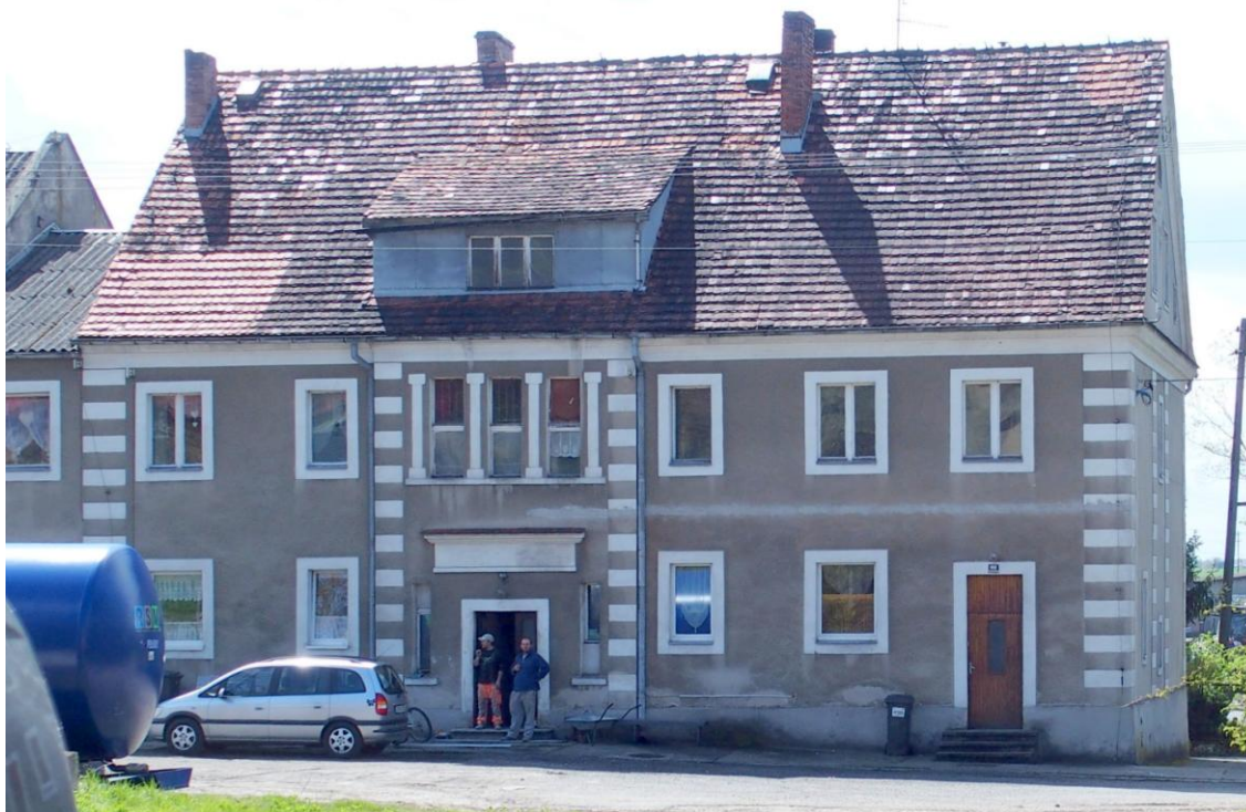
Widok budynku od północy
