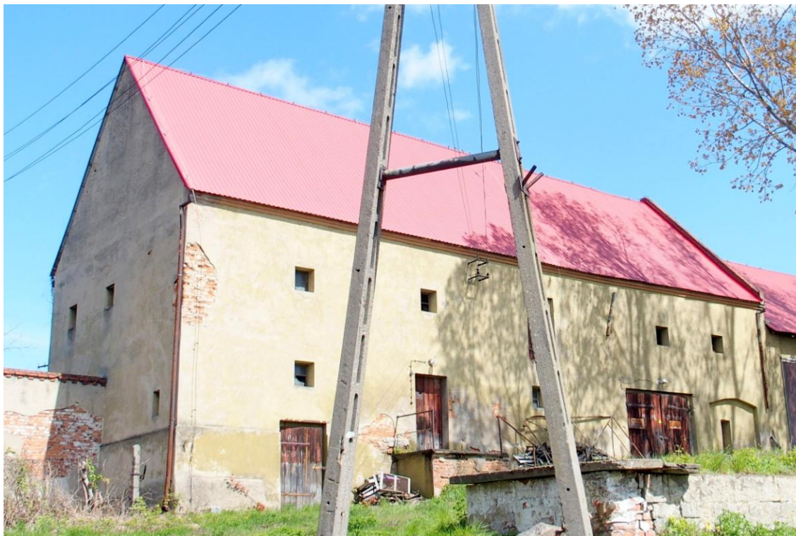
Widok budynku od południowego-zachodu
