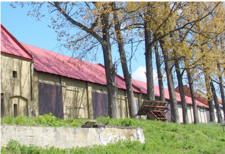
Stodoły, widok budynków od południowego-zachodu
