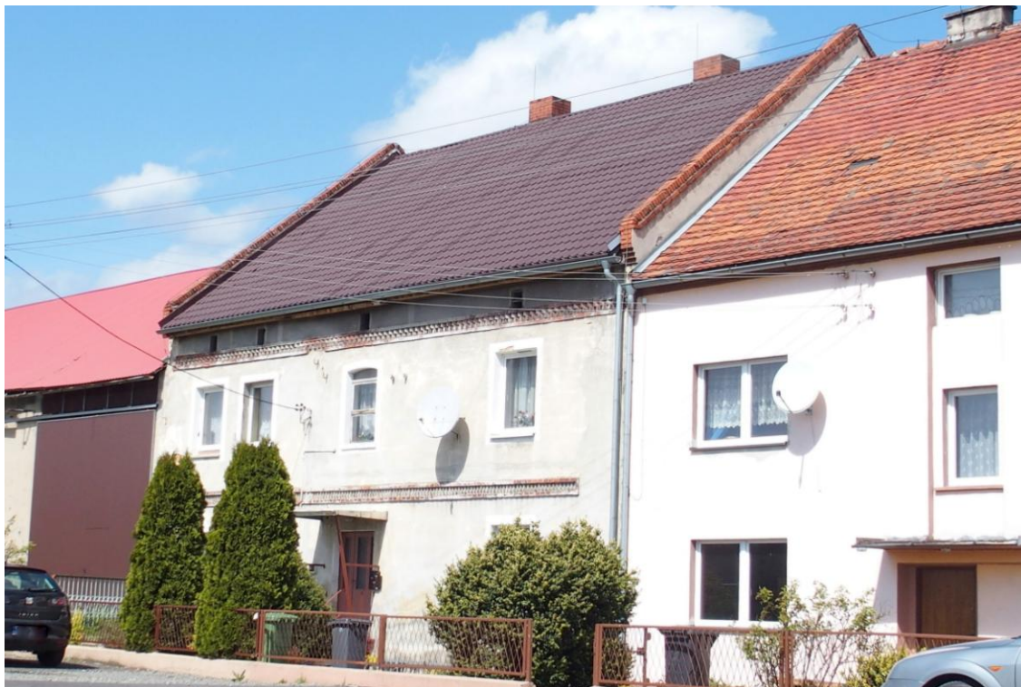
Widok budynku od południowego-wschodu
