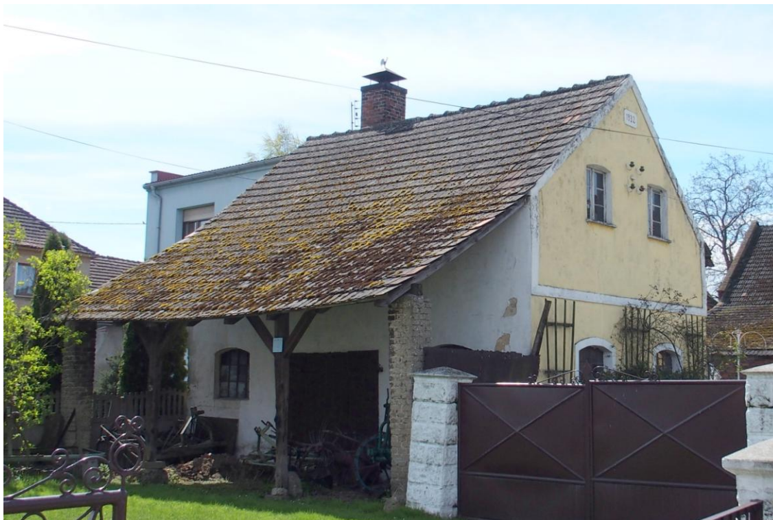
Widok budynku od północy
