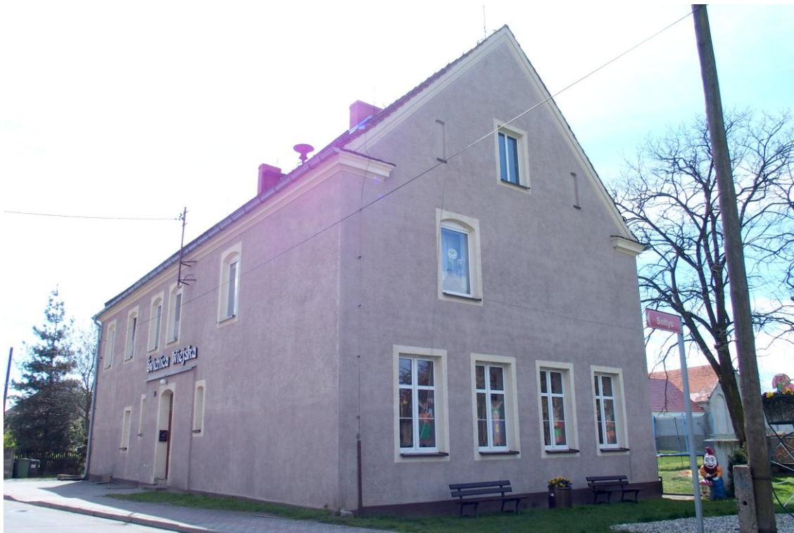
Widok budynku od północy
