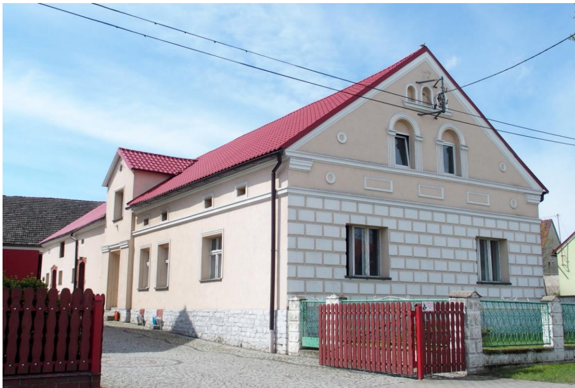
Widok budynku od północnego-zachodu
