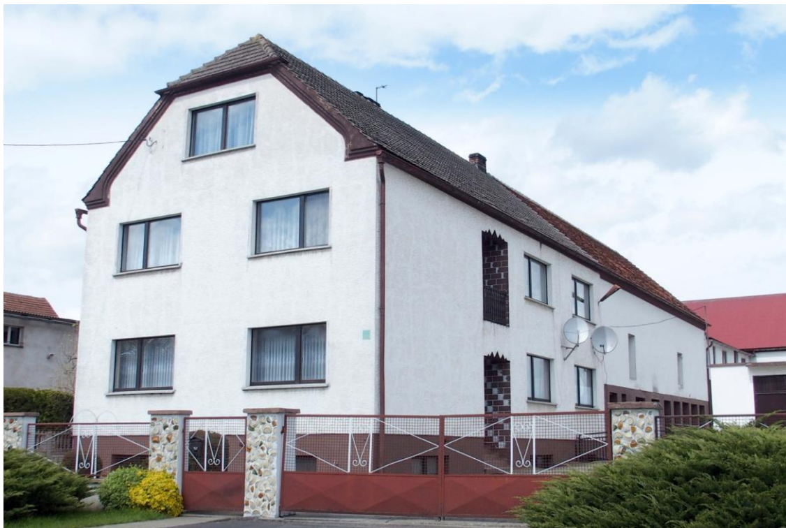
Widok budynku od południowego-wschodu
