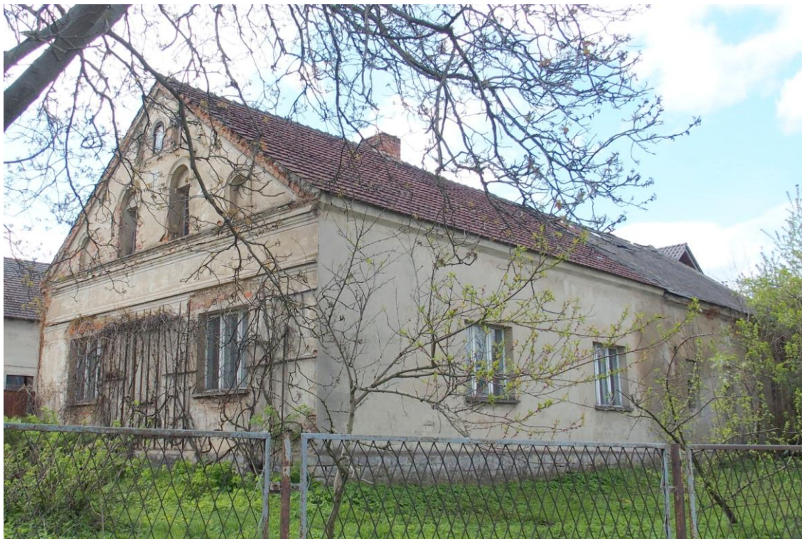
Widok budynku od północnego-wschodu
