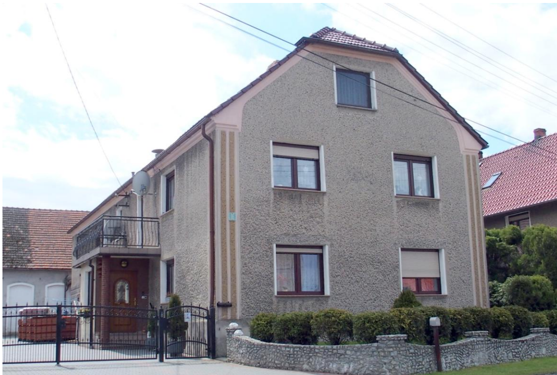
Widok budynku od północnego-wschodu
