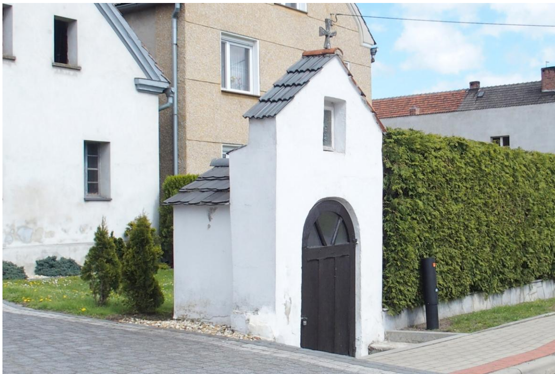
Widok od południowego-zachodu
