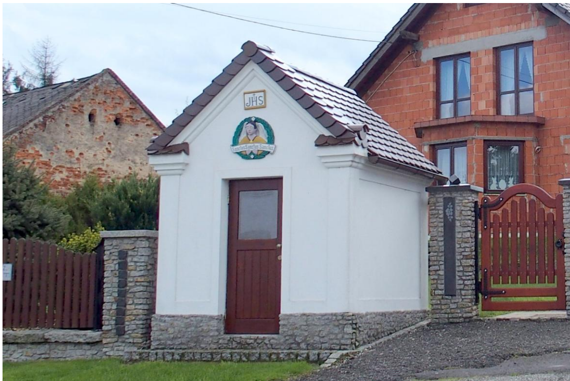
Widok od północnego-zachodu
