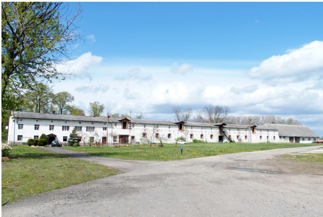
Widok budynku od południowego-wschodu
