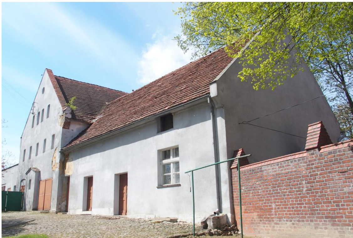
Widok budynku od wschodu
