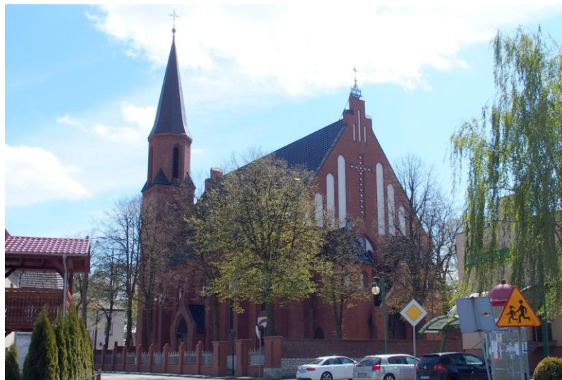
Widok od północno-zachodu
