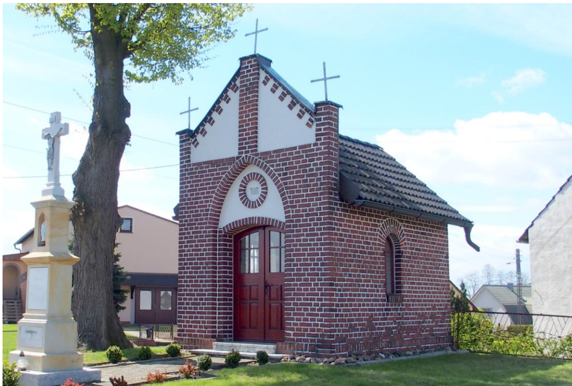
Widok budynku od północnego-wschodu
