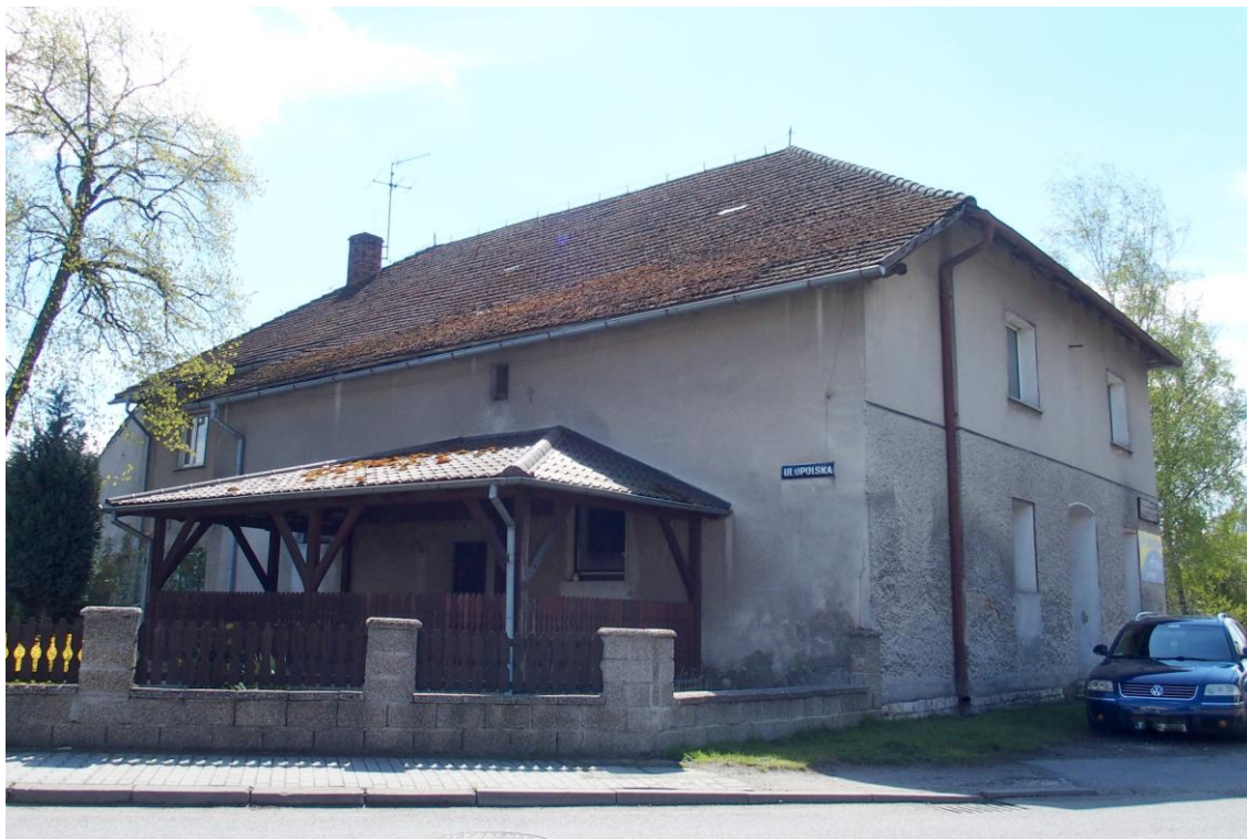
Widok budynku od północy
