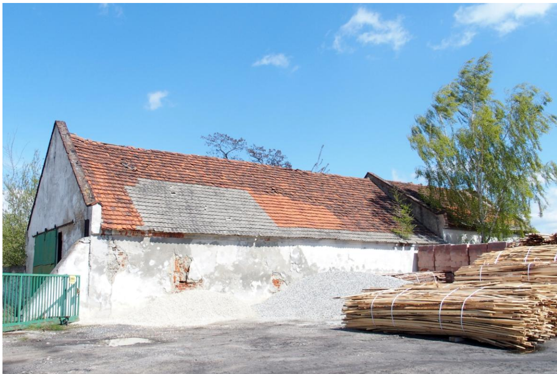
Widok budynku od południowego-zachodu
